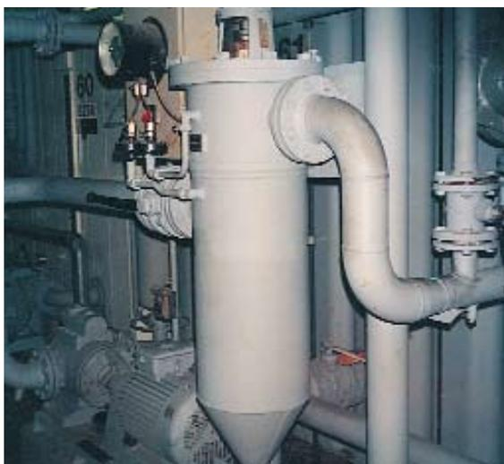
*Автоматический кромочный щелевой фильтр со скребковой очисткой для фильтрации изоцианата (один из компонентов для синтеза полиуретана).*
